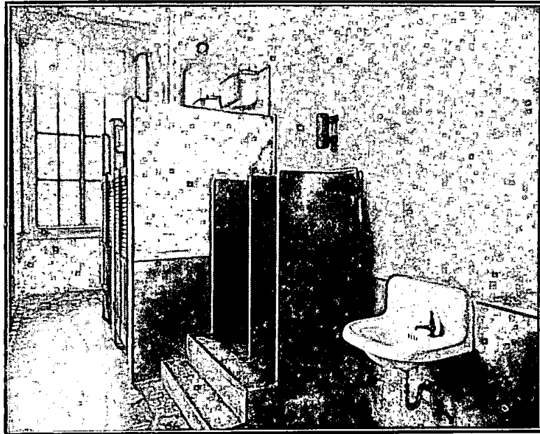
Una instalación higiénica.
